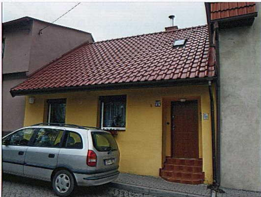
Widok od południowego- zachodu.
