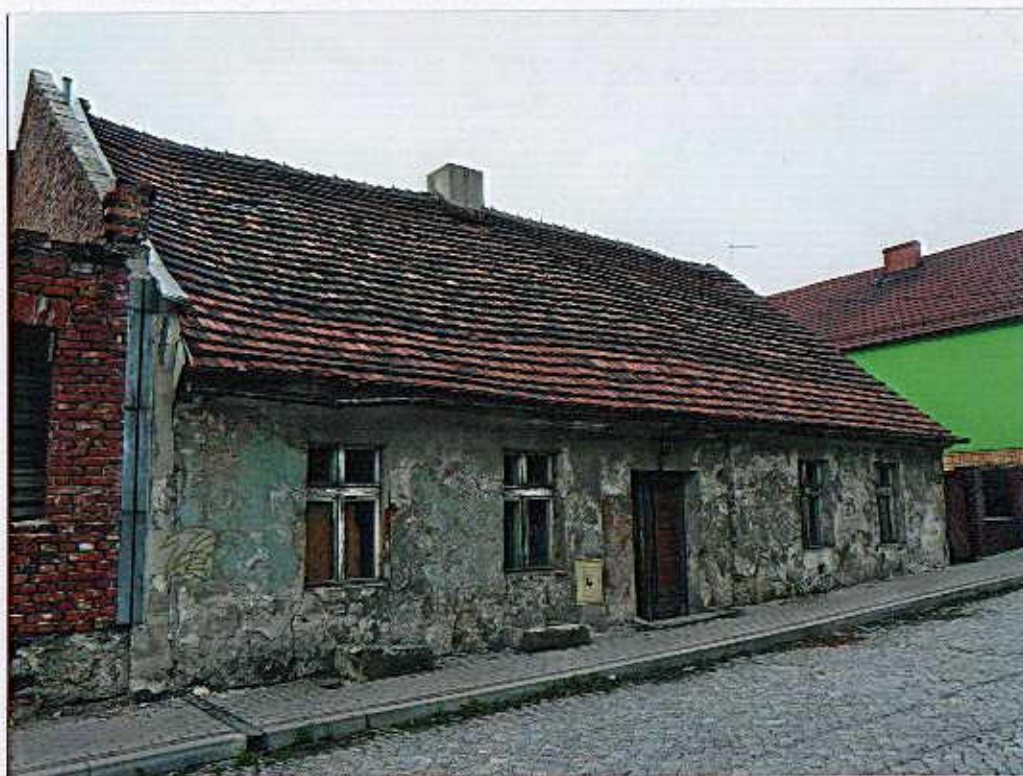
Widok od południowego- zachodu.
