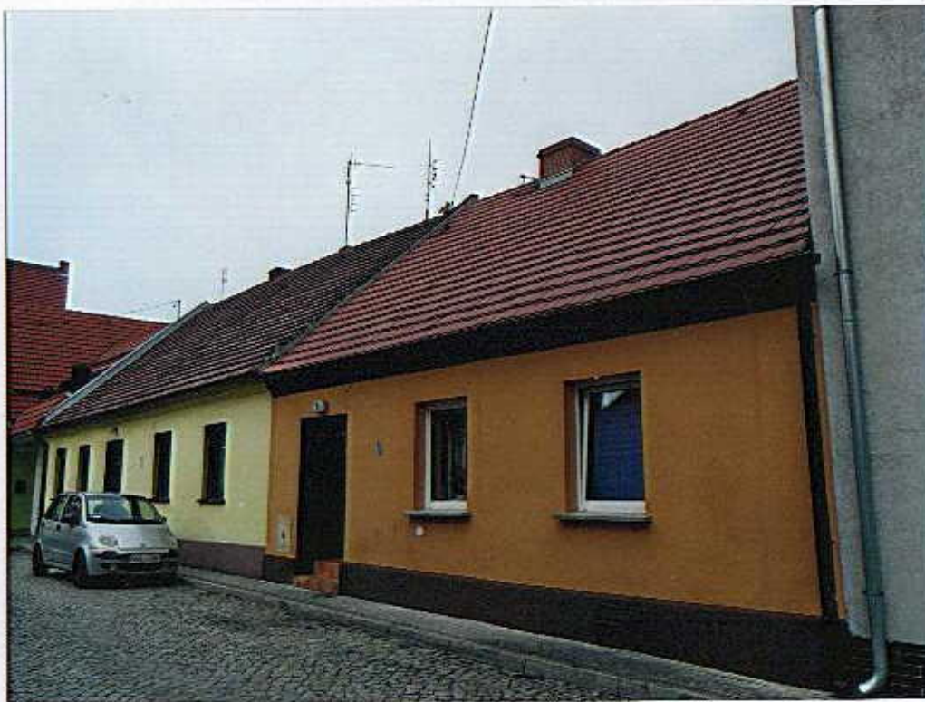
Widok od południowego- zachodu.
