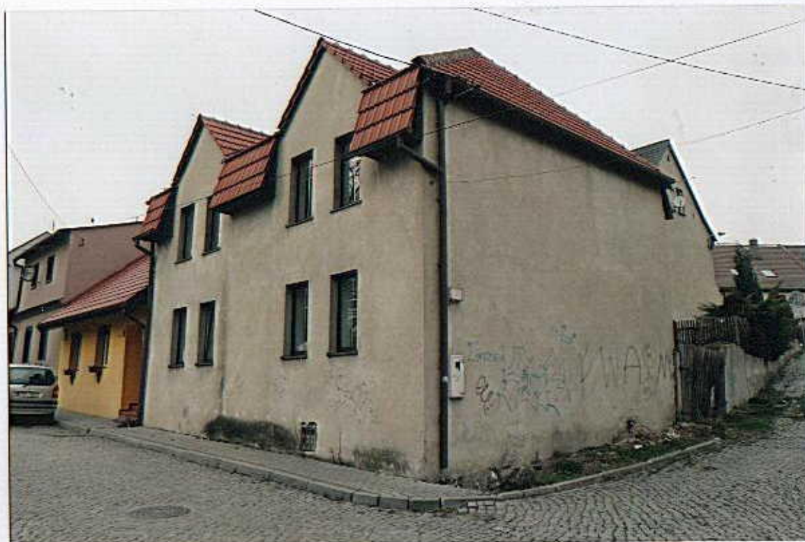
Widok od południowego- wschodu.
